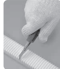
フレキの切断はカッター等で波形の谷で切って下さい。
